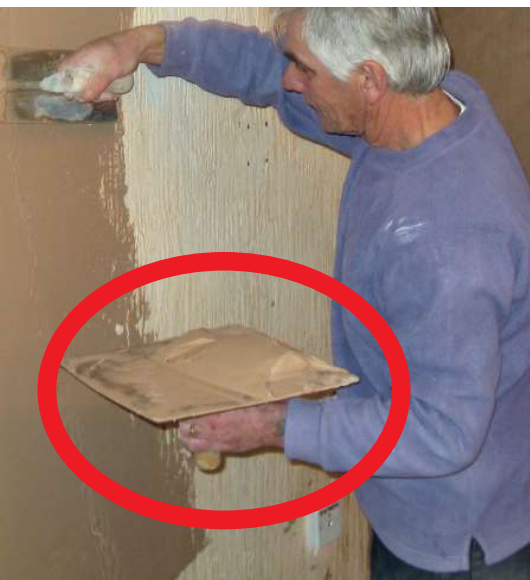
Plâtrier avec mortier.
